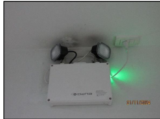
รูปที่ 53 ไฟฉุกเฉิน ระบบไฟสำรองฉุกเฉิน
