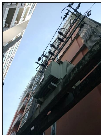
รูปที่ 29 หม้อแปลงไฟฟ้าของโครงการ
