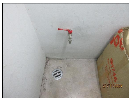
รูปที่ 26 ท่อระบายน้ำชะล้างห้องพักมูลฝอยในแต่ละชั้น
