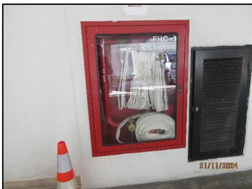
รูปที่ 48 ตู้ดับเพลิง และถังดับเพลิง
