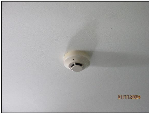
รูปที่ 46 (ต่อ) อุปกรณ์ตรวจจับควัน ตรวจจับความร้อน
