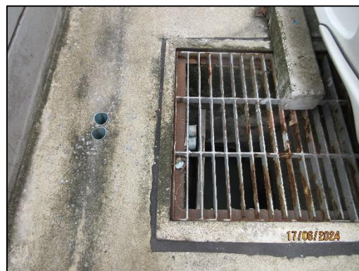
รูปที่ 17 ท่อระบายน้ำ พร้อมตะแกรงดักขยะ
