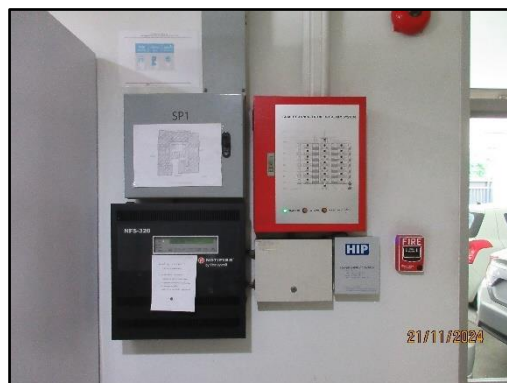
รูปที่ 55 Graphic annunciator fire alarm system
