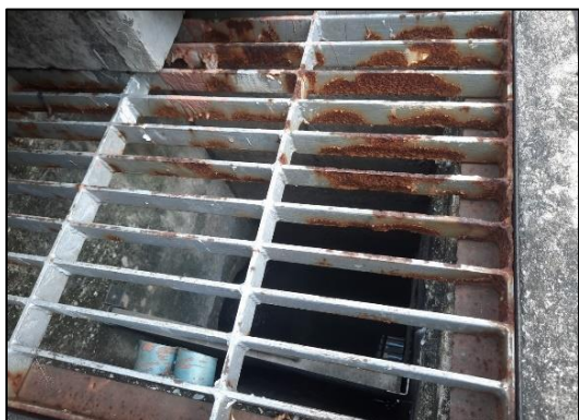
รูปที่ 17 ท่อระบายน้ำ พร้อมตะแกรงดักขยะ
