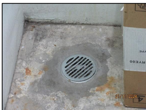
รูปที่ 26 ท่อระบายน้ำชะล้างห้องพักมูลฝอยในแต่ละชั้น
