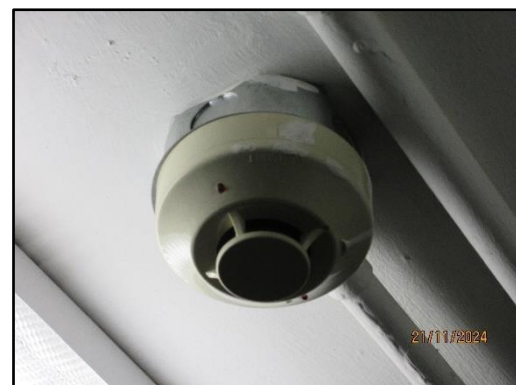
รูปที่ 46 อุปกรณ์ตรวจจับควัน ตรวจจับความร้อน
