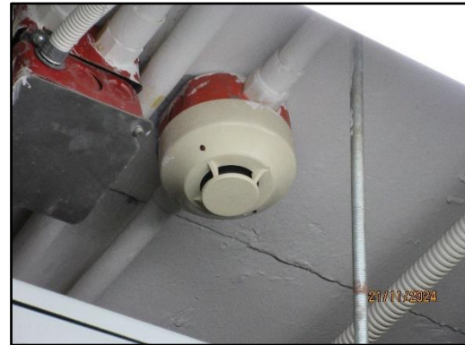
รูปที่ 46 (ต่อ) อุปกรณ์ตรวจจับควัน ตรวจจับความร้อน
