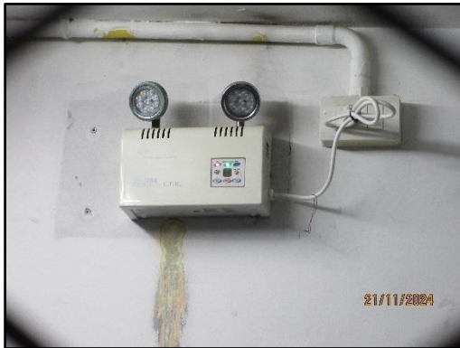
รูปที่ 53 ไฟฉุกเฉิน ระบบไฟสำรองฉุกเฉิน
