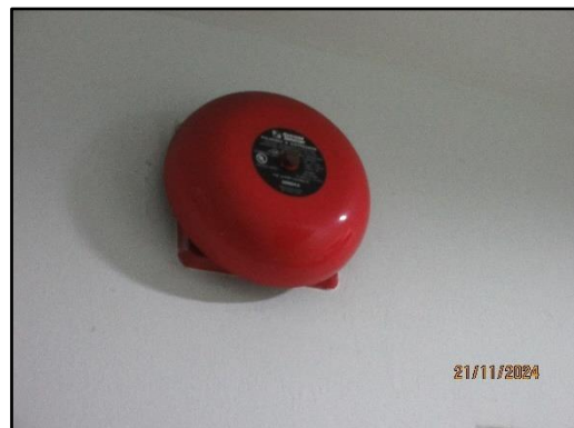
รูปที่ 45 ชุดกดแจ้งเหตุและกระดิ่งแจ้งสัญญาณเพลิงไหม้
