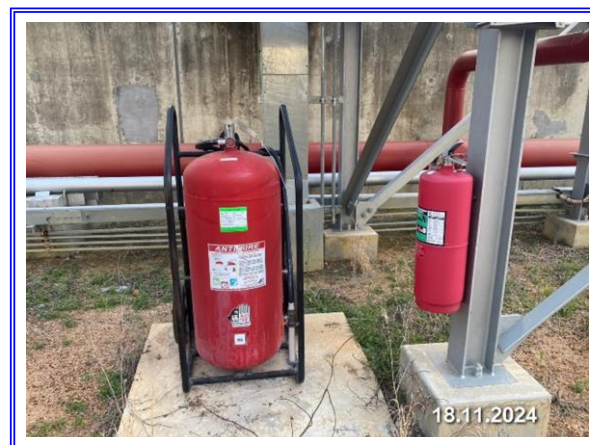
รูปที่ 3-6 ถังดับเพลิงชนิดมือถือ บริเวณคลังน้ำมัน
