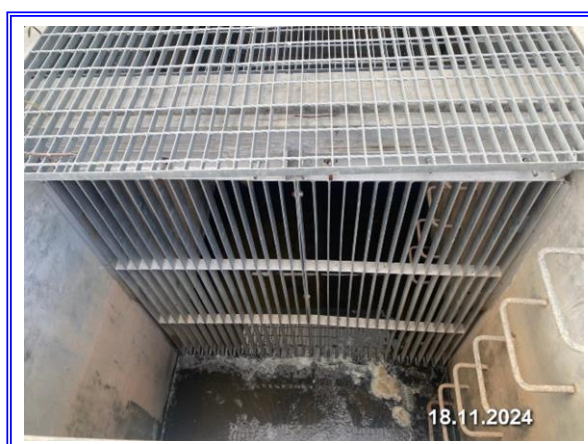
รูปที่ 3-12 ตะแกรงดักเศษขยะ บริเวณบ่อพักน้ำทิ้ง (Holding Pond)
