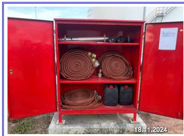
รูปที่ 3-8 ตู้อุปกรณ์ดับเพลิง (Fire Hose)
