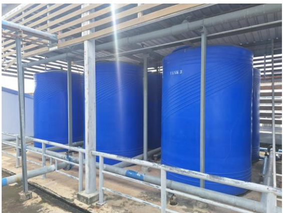
รูปที่ 2-12 ถังสำรองน้ำใต้ดิน และถังสำรองน้ำชั้นดาดฟ้า
