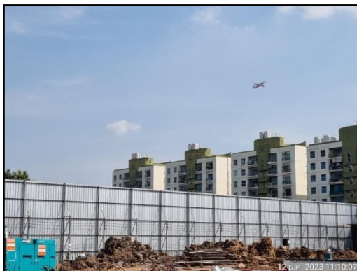
รั้วทึบ (Mesh Sheet) ความสูง 6 เมตร โดยรอบพื้นที่โครงการ
