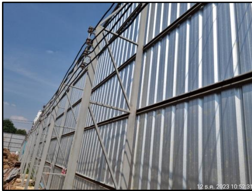
รูปที่ 33 ติดตั้งเสาโครงเหล็กค้ำยัน และโครงเหล็กแนวนอนยึดติดกับเสาโครงเหล็กยาวตลอดแนวรั้ว
