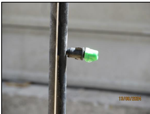
รูปที่ 10 ติดตั้งระบบสเปรย์น้ำรอบบริเวณพื้นที่ก่อสร้าง
