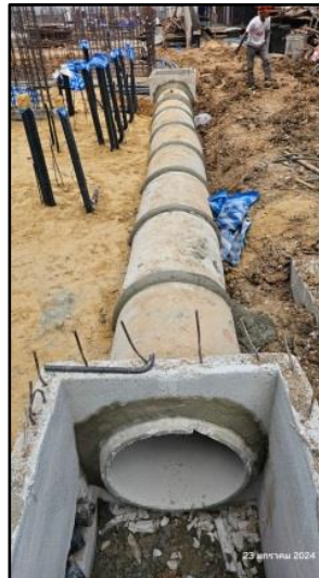
รูปที่ 56 ร่องระบายน้ำภายในพื้นที่โครงการ
