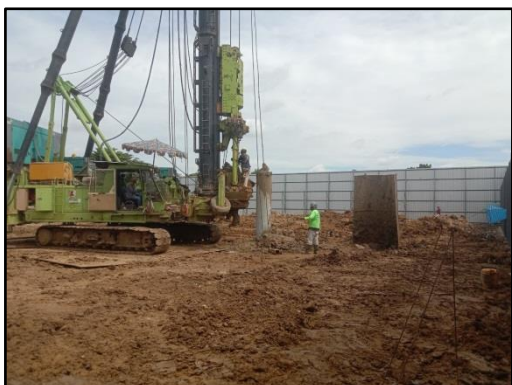
รูปที่ 41 การทดสอบการรับน้ำหนักของเสาเข็ม (Dynamic Load Test) และการติดตั้งเสาเข็ม
