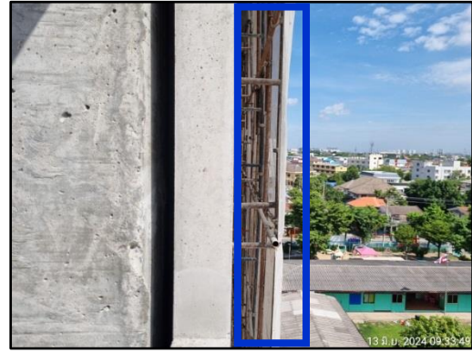
รูปที่ 30 (ต่อ) ติดตั้งผ้าใบก่อสร้าง Mesh Sheet ตั้งแต่ชั้นล่างจนถึงชั้นสูงสุดของอาคารโครงการ ด้านที่ติดกับโรงเรียนอนุบาลดวงจิต (ทิศเหนือ)
