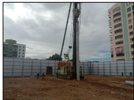
รูปที่ 41 การทดสอบการรับน้ำหนักของเสาเข็ม (Dynamic Load Test) และการติดตั้งเสาเข็ม
