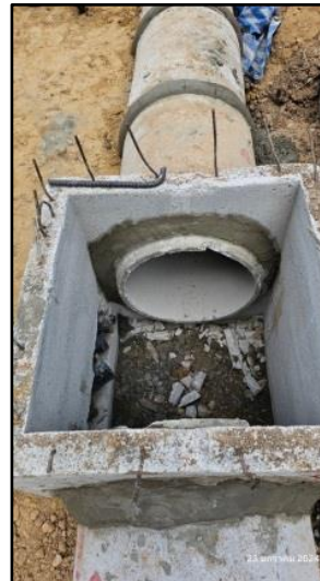
รูปที่ 56 ร่องระบายน้ำภายในพื้นที่โครงการ
