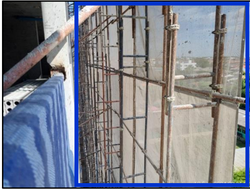
รูปที่ 30 (ต่อ) ติดตั้งผ้าใบก่อสร้าง Mesh Sheet ตั้งแต่ชั้นล่างจนถึงชั้นสูงสุดของอาคารโครงการ ด้านที่ติดกับโรงเรียนอนุบาลดวงจิต (ทิศเหนือ)
