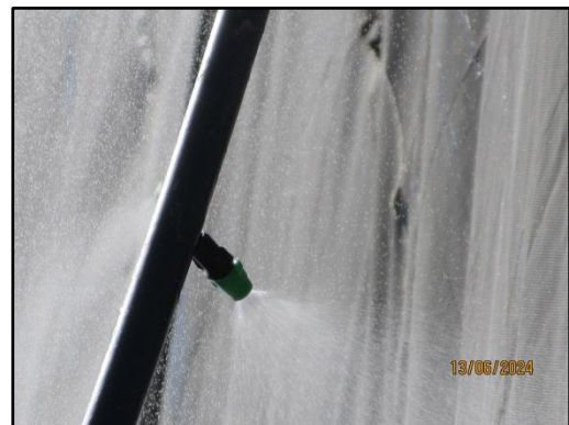
รูปที่ 10 ติดตั้งระบบสเปรย์น้ำรอบบริเวณพื้นที่ก่อสร้าง
