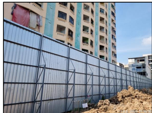
รั้วทึบ (Mesh Sheet) ความสูง 6 เมตร โดยรอบพื้นที่โครงการ
