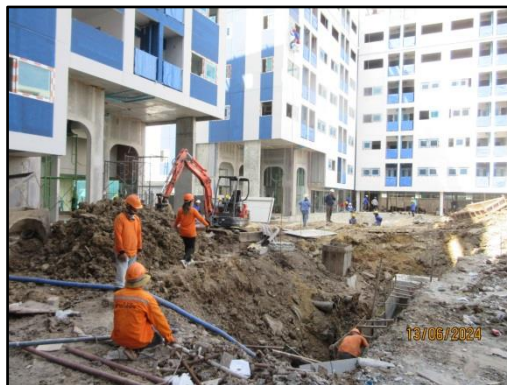
รูปที่ 15 เปิดพื้นที่ขุดดินเท่าที่จำเป็นเท่านั้น และต้องปิดหน้าดินด้วยคอนกรีตหรือปิดคลุมด้วยผ้าใบ
