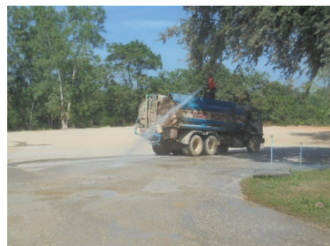
รูปที่ 2-41: การฉีดพรมน้ำเส้นทางขนส่งแร่
