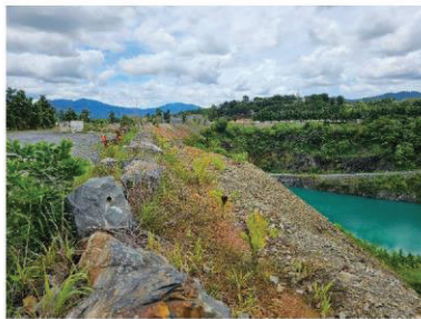
รูปที่ 8: คั่นทำนบดินบริเวณขอบบ่อเหมือง
