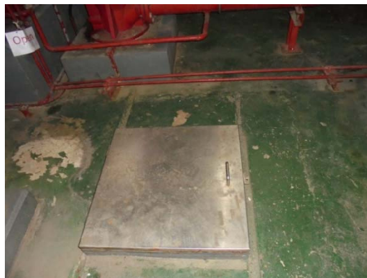
ภาพที่ 4-24 สภาพฝาลังสำรอน้ำใต้ดิน ปิดมิดชิดและมีขอบยกสูงจากพื้น
