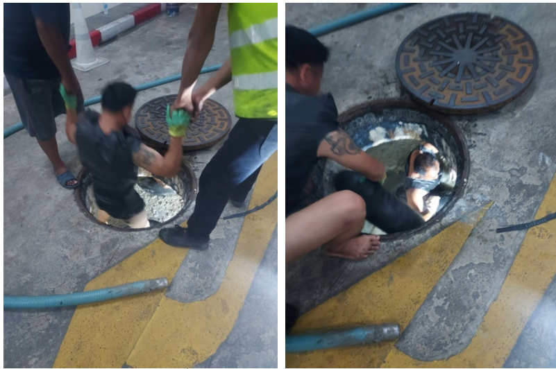
ภาพที่ 4-27 คูตตะกอนไขมันในบ่อดักไขมัน
