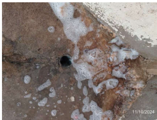
รูปที่ 2-16 ท่อรวบรวมน้ำจากการล้าง ห้องพักมูลฝอย
