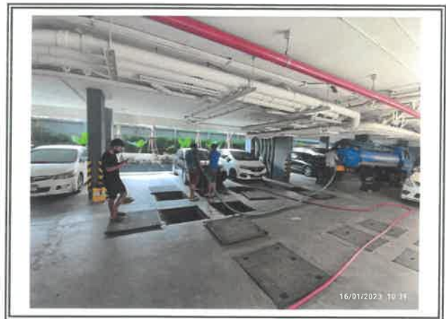
รูปที่ 2-11 การสูบล้างตะกอน
