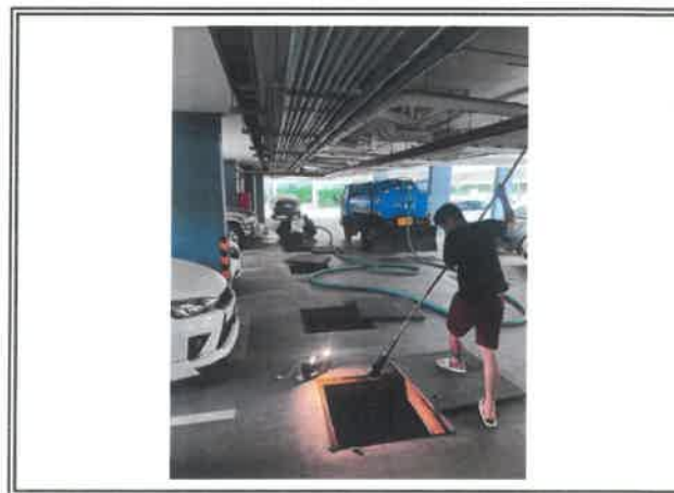
รูปที่ 2-12 การสูบล้างไขมัน
