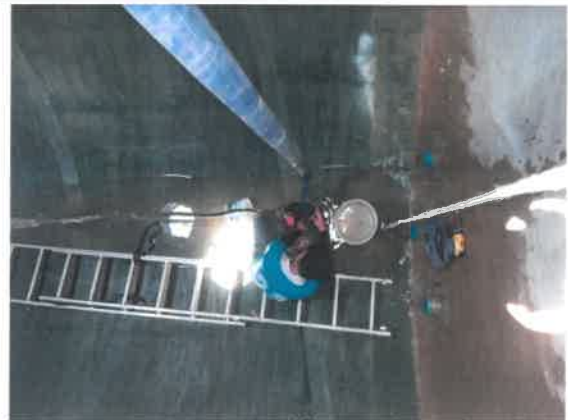
รูปที่ 2-59 การล้างทำความสะอาดถังเก็บน้ำสำรอง
