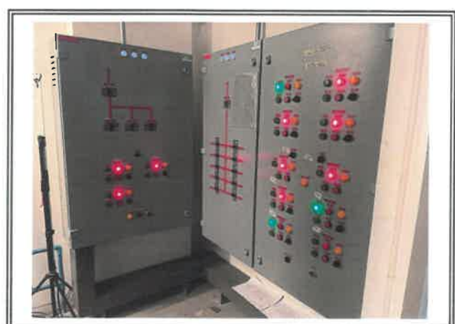
รูปที่ 2-14 สวิตช์แยกระบบบำบัดน้ำเสีย
