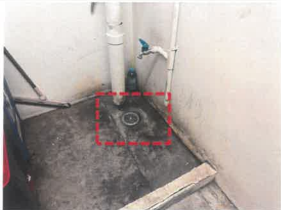
รูปที่ 2-58 ตะแกรงครอบรูท่อระบายน้ำ
