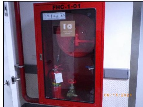
ตู้เก็บสายส่งน้ำดับเพลิงและอุปกรณ์ดับเพลิง
