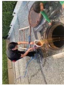
การสูบลบก่อนจากระบบบำบัดน้ำเสีย
