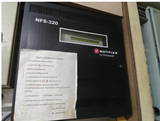
รูปที่ 41 ตู้ควบคุมระบบแจ้งเหตุเพลิงไหม้
