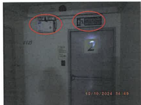
รูปที่ 16 ระบบหนีไฟ ได้แก่ บันไดหนีไฟ ระบบไฟฟ้าส่องสว่างสำรอง และป้ายบอกทางหนีไฟ
