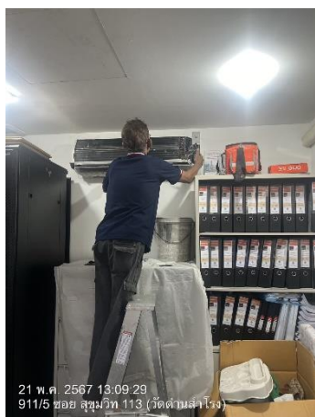
รูปที่ 47 การล้างทำความสะอาดเครื่องปรับอากาศ ในพื้นที่ส่วนกลาง
