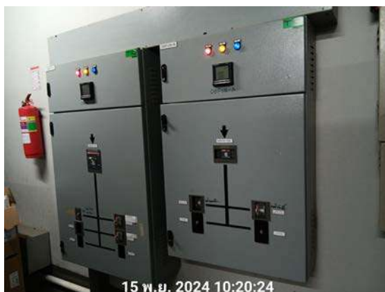
รูปที่ 2.33 ตู้ MDB ( Main Distribution Board )
