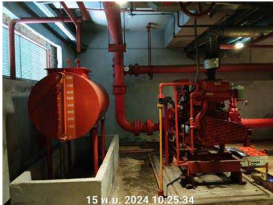
รูปที่ 2.31 ระบบ fire pump
