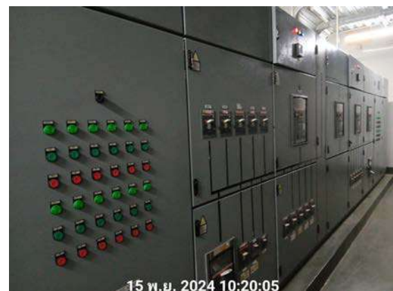
รูปที่ 2.33 ตู้ MDB ( Main Distribution Board )
