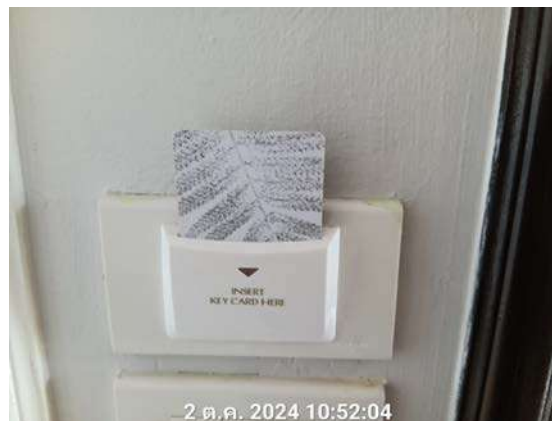
รูปที่ 2.24 กุญแจตัดไฟอัตโนมัติในห้องพัก
