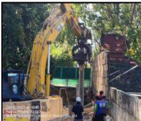
กดเสาเข็มโดยใช้ Vibro Hammer แทนการตอก
