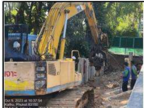
กดเสาเข็มโดยใช้ Vibro Hammer แทนการตอก
