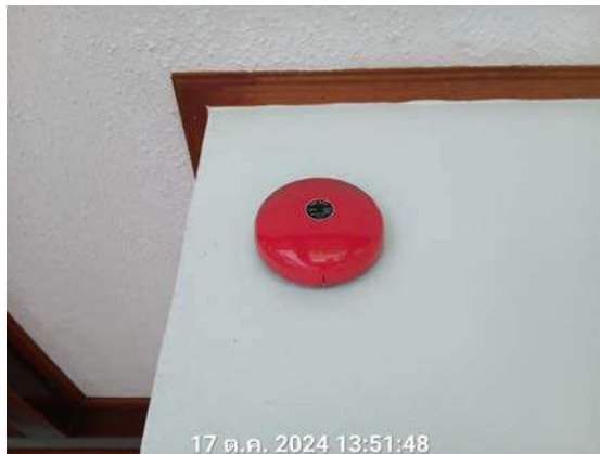
รูปที่ 2.21 อุปกรณ์แจ้งเหตุเพลิงไหม้
