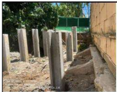
กดเสาเข็มโดยใช้ Vibro Hammer แทนการตอก
