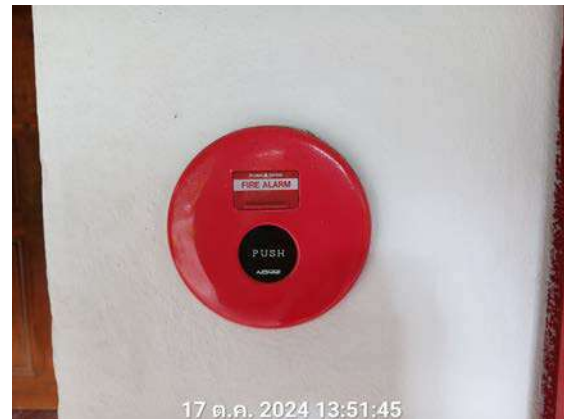
รูปที่ 2.21 อุปกรณ์แจ้งเหตุเพลิงไหม้
