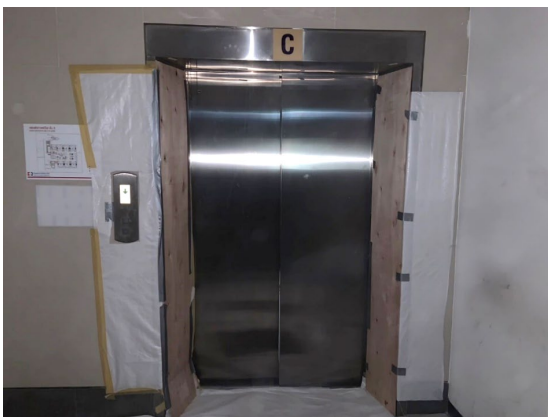
รูปที่ 2-9 การปิดประตูหน้าต่างเพื่อป้องกันฝุ่นและเสียงจากการก่อสร้าง
