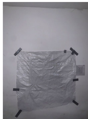
รูปที่ 2-9 การปิดประตูหน้าต่างเพื่อป้องกันฝุ่นและเสียงจากการก่อสร้าง
