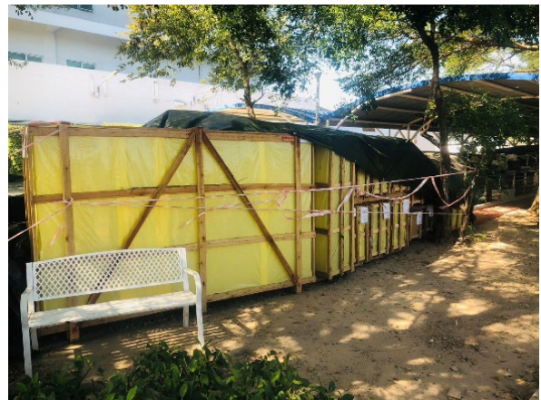
รูปที่ 2-2 ติดตั้งผ้าใบคลุมวัสดุก่อสร้าง และกั้นพื้นที่วางวัสดุก่อสร้าง
