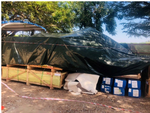
รูปที่ 2-2 ติดตั้งผ้าใบคลุมวัสดุก่อสร้าง และกั้นพื้นที่วางวัสดุก่อสร้าง
