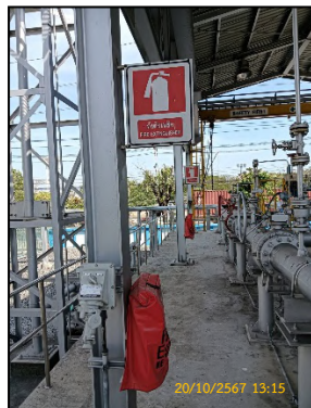
ภาพที่ 2.2-2 เครื่องดับเพลิงแบบเคมีผง บริเวณสถานีวัดและควบคุมแรงดันก๊าซ (MRS)
