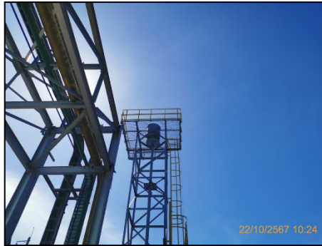
ภาพที่ 2.2-6 Stack Silencer
