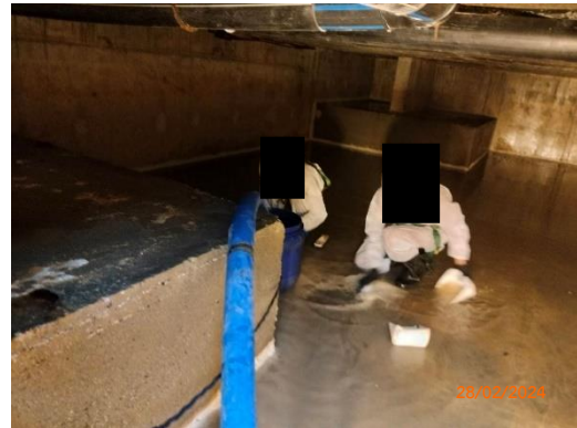
รูปที่ 59 การทำความสะอาดถังเก็บน้ำใช้
