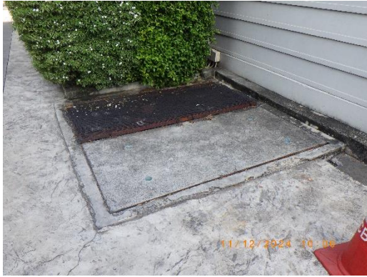
รูปที่ 8 บ่อทรวางน้ำและท่อระบายน้ำ
