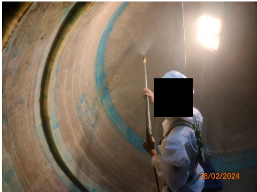
รูปที่ 59 การทำความสะอาดถังเก็บน้ำใช้
