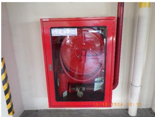
รูปที่ 19 ตู้เก็บอุปกรณ์ดับเพลิง
