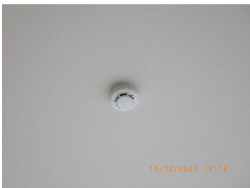
รูปที่ 62 เครื่องตรวจจับควัน
