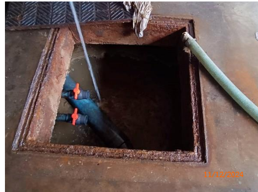
รูปที่ 44 การสูบน้ำจากตะกอนส่วนเกินออกจากระบบบำบัดน้ำเสีย
