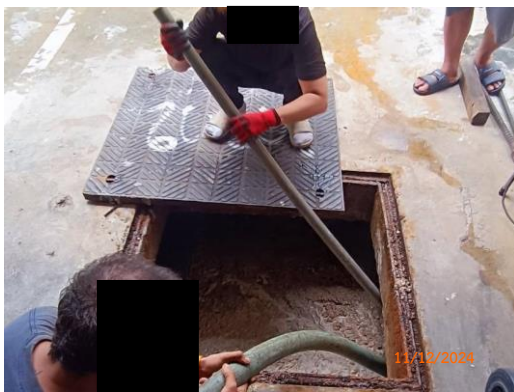
รูปที่ 45 การตัดไขมันจากถังตกไขมันของระบบบำบัดน้ำเสีย
