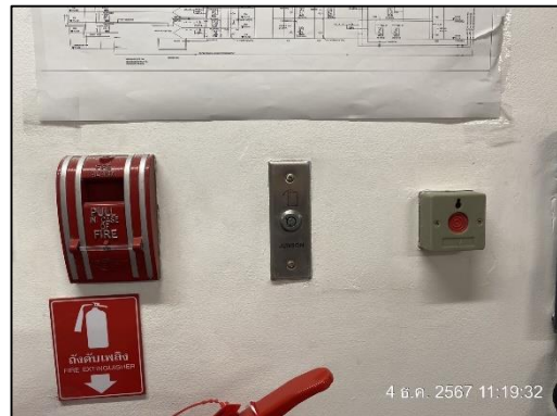
ภาพที่ 47 โทรศัพท์ฉุกเฉิน/อุปกรณ์แจ้งเหตุแบบใช้มือดึง
