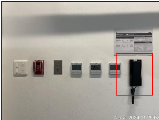
ภาพที่ 47 โทรศัพท์ฉุกเฉิน/อุปกรณ์แจ้งเหตุแบบใช้มือดึง
