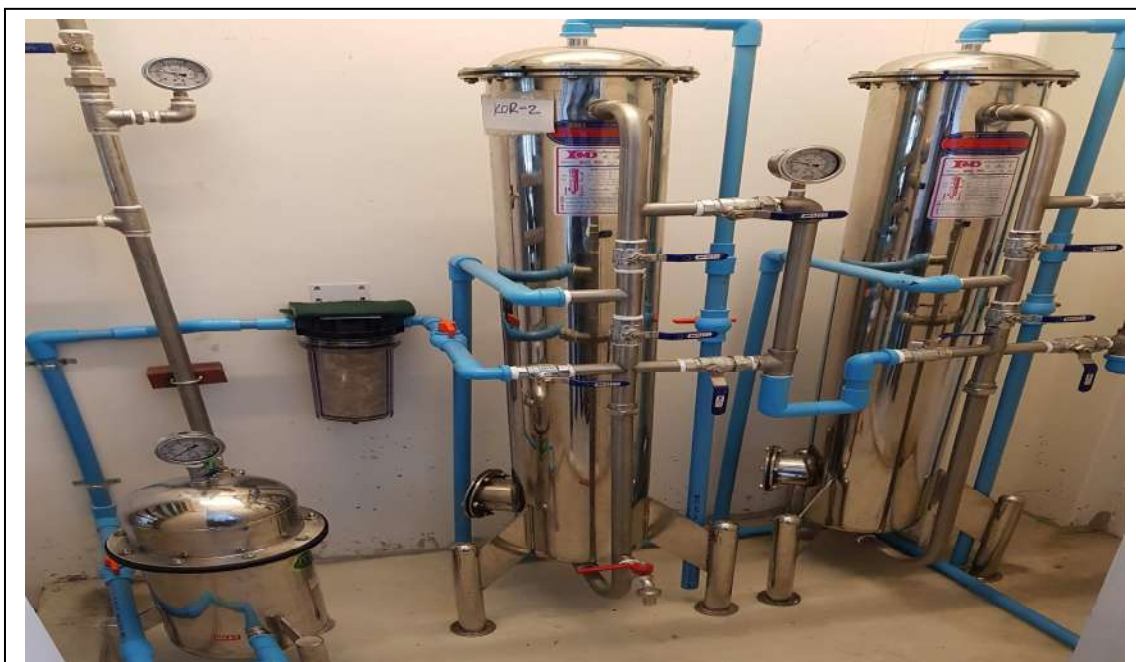
ภาพที่ 2-19 ระบบกรองน้ำดื่มประจำครัวและร้านอาหารของโครงการ
