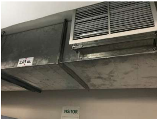
ภาพที่ 2-2 พัดลมดูดอากาศลานจอดรถใต้ดิน
