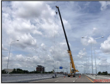
การติดตั้งอุปกรณ์งานทางบนโครงสร้างสะพานยกระดับ (โครงการฯ ตอน 2)
