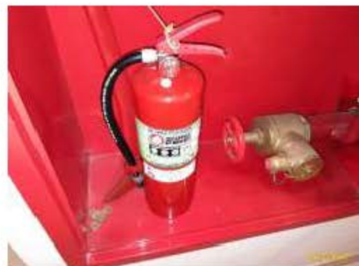
ตู้เก็บสายฉีดน้ำดับเพลิงและท่ออื่น
