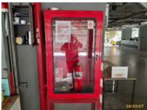
ตู้เก็บสายฉีดน้ำดับเพลิงและท่ออื่น
