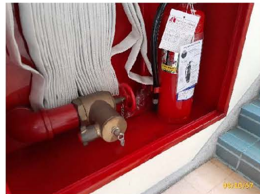
ท่อท่อน้ำดับเพลิงระบบท่อแห้ง
