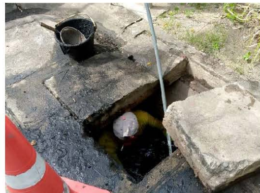
ภาพที่ 2.2-4 การขุดลอกระบบระบายน้ำ
