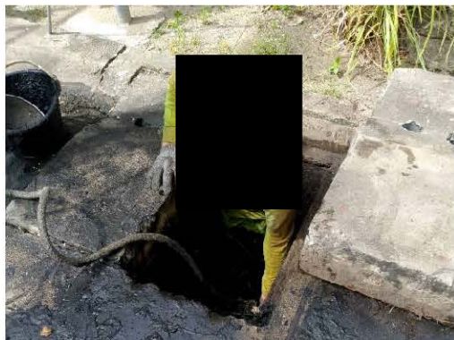
ภาพที่ 2.2-4 การขุดลอกระบบระบายน้ำ
