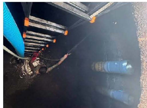
ภาพที่ 2.2-20 การสูบล้างระบบบำบัดน้ำเสีย
