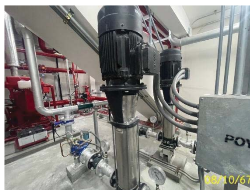
เครื่องปั้มน้ำสำหรับอุปโภค-บริโภค ชั้นใต้ดิน
