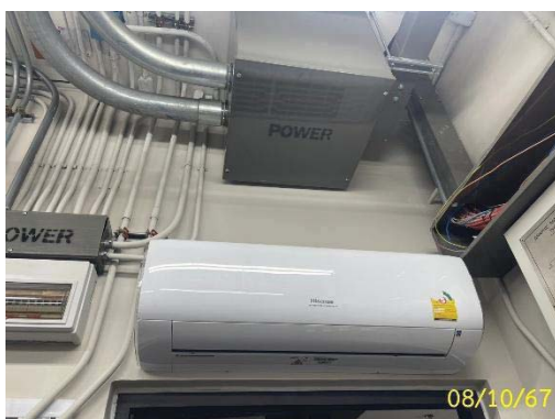
การระบายอากาศโดยใช้ระบบปรับอากาศ
