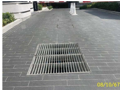
บริเวณบ่อพักน้ำทั้งออกสู่ท่อระบายน้ำสาธารณะ
