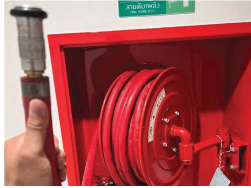
ตรวจสอบ สายยางดับเพลิง
