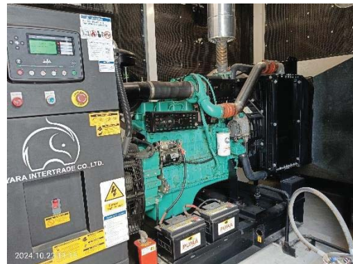
เครื่องกำเนิดไฟฟ้าสำรองสำหรับอาคารพาณิชย์
