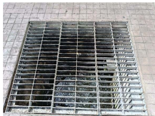
ตะแกรงดักขยะ ในบ่อพักน้ำสุดท้าย
