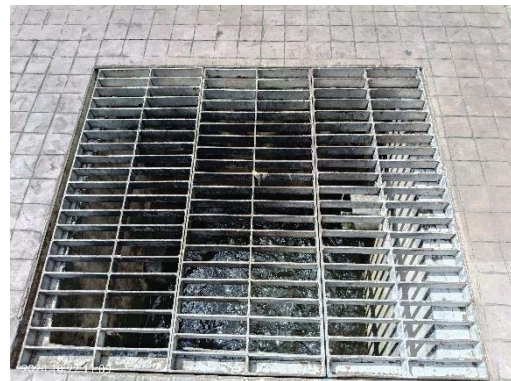
บ่อพักน้ำสุดท้ายก่อนปล่อยออกนอกโครงการ
