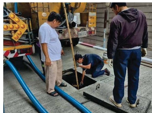
สูบลบคอนกรีตส่วนเกินและสูบล้างไขมันออกจากระบบบำบัดน้ำเสีย
