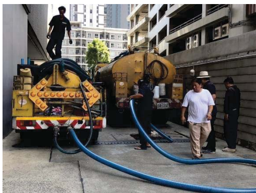
สูบลบคอนกรีตส่วนเกินและสูบล้างไขมันออกจากระบบบำบัดน้ำเสีย
