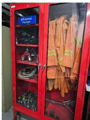
รูปที่ 37 ตู้เก็บอุปกรณ์ Fire Man
