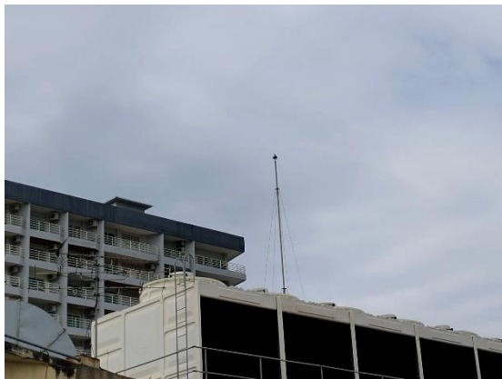
รูปที่ 41 ระบบป้องกันฟ้าผ่า
