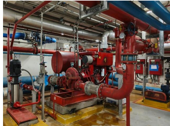
รูปที่ 40 ระบบเครื่องสูบน้ำดับเพลิง (Fire Pump System)
