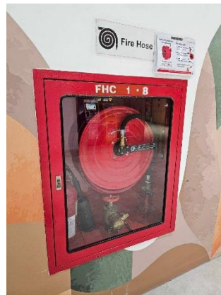
รูปที่ 38 ตู้ดับเพลิง (Fire Hose Cabinet)
