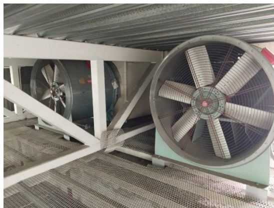
รูปที่ 29 ระบบระบายอากาศทั้งจากอาคาร
