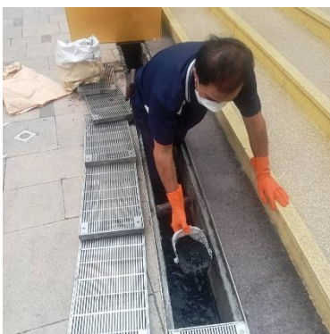
รูปที่ 59 ทำความสะอาดระบบระบายน้ำ
