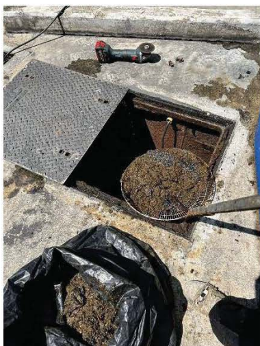
สูบลตะกอน และกากไขมันระบบบำบัดน้ำเสีย (29-30/10/67)
