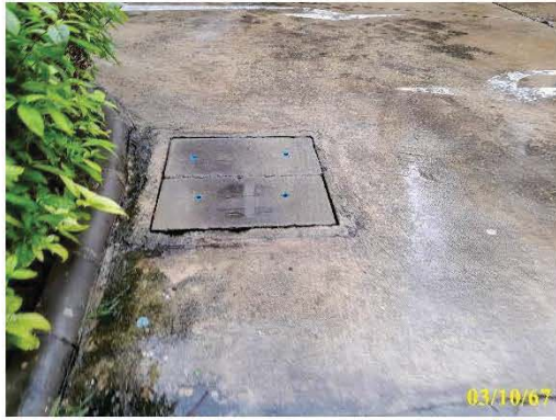
ท่อระบายน้ำและบ่อตรวจสอบการระบายน้ำ
