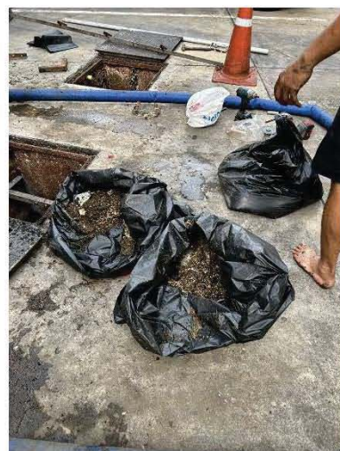
สูบลตะกอน และกากไขมันระบบบำบัดน้ำเสีย (29-30/10/67)
