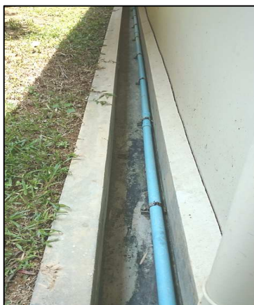
ภาพที่ 2-3 รางระบายน้ำฝนภายในโครงการ
