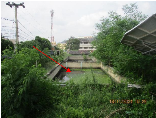
รูปที่ 2-7 บ่อพักน้ำทิ้ง ก่อนนำไปใช้รดน้ำต้นไม้
