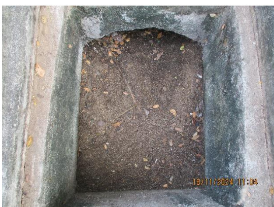
รูปที่ 2-11 บ่อดักตะกอนของรางระบายน้ำฝนที่ตกในพื้นที่ โรงแรม ก่อนระบายออกจากพื้นที่
