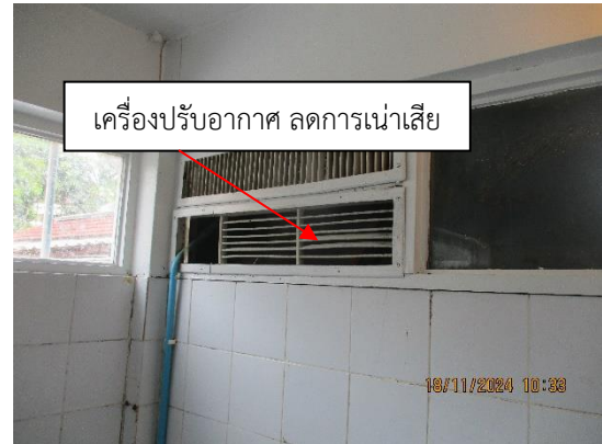
รูปที่ 2-14 เครื่องปรับอากาศและระบบระบายอากาศ ภายในห้องพักขยะทั่วไป
