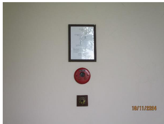
รูปที่ 2-23 เครื่องส่งสัญญาณเตือนไฟไหม้ภายในอาคาร และแผนผังแสดงเส้นทางหนีไฟ
