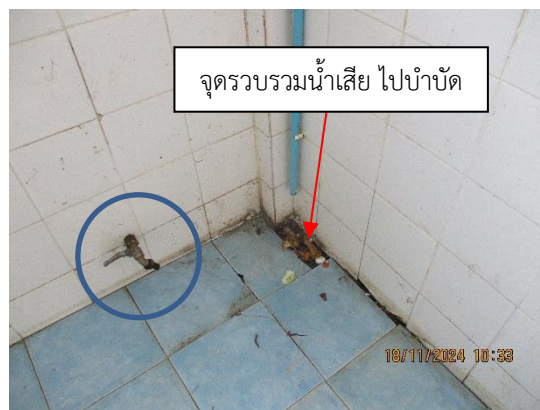
รูปที่ 2-35 ภายในห้องพักขยะทั่วไป มีก๊อกน้ำ และจุดรวบรวมน้ำจากการล้างพื้นห้องพัก
