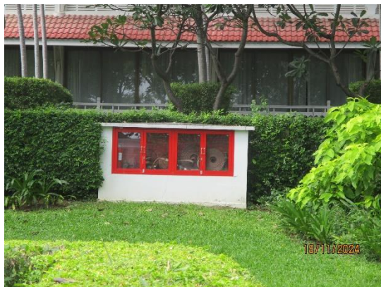
รูปที่ 2-30 ตู้เก็บสายฉีดน้ำดับเพลิงภายนอกอาคาร
