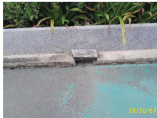
ท่อระบายน้ำฝนชั้นลาดฟ้า
