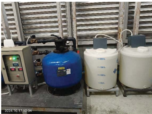
ระบบสำหรับควบคุมเชื้อลิจิโอนเนลลาในหอผึ่งเย็น
