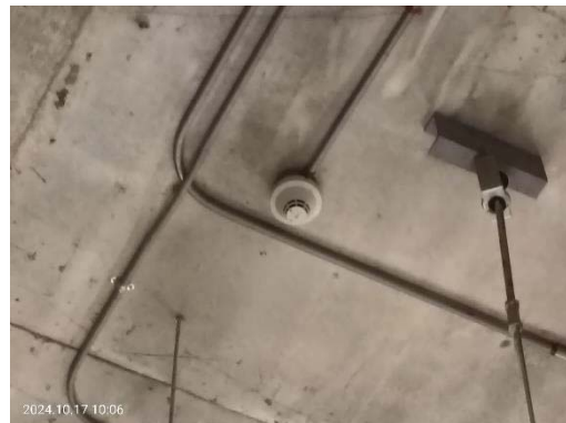
เครื่องตรวจจับความร้อนในห้อง Generator
