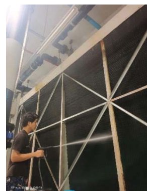
ระบบสำหรับควบคุมเชื้อลิจิโอนเนลลาในหอผึ่งเย็น
