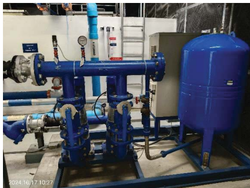
Booster Pump ควบคุมแรงดันน้ำ ชั้น 35
