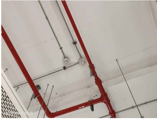
เครื่องตรวจจับความชื้นและความร้อนในห้องหม้อแปลงไฟฟ้า
