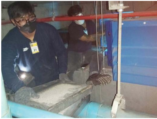
ตรวจสอบระบบ UV ที่ดูอากาศจากระบบบำบัดน้ำเสีย เปลี่ยน ถ่าน Activated Carbon ระบบบำบัด Aerosol
