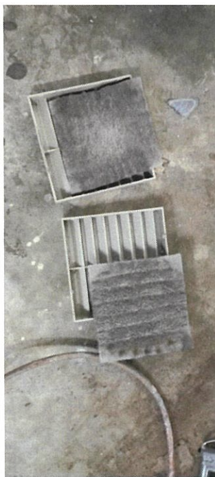
Fig 3. ทำความสะอาดแผ่นกรองอากาศ
