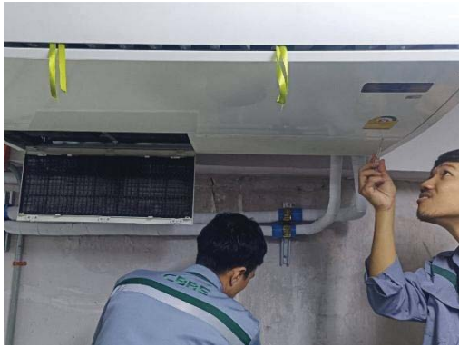
การทำความสะอาดและซ่อมแซมเครื่องปรับอากาศ
