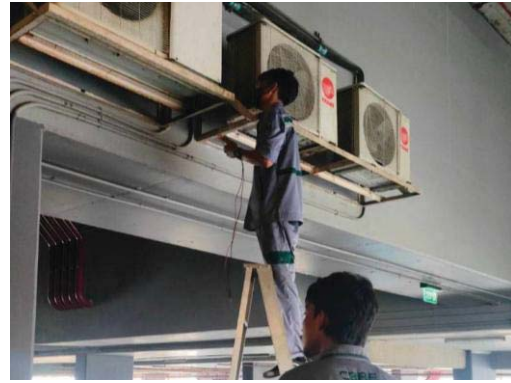
การทำความสะอาดและซ่อมแซมเครื่องปรับอากาศ
