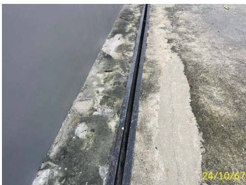
รางระบายน้ำและท่อพักน้ำรอบโครงการ
