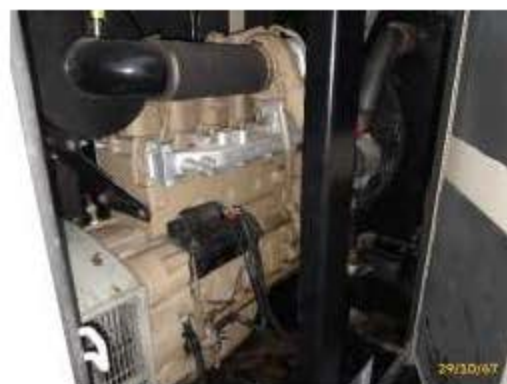
ตู้ควบคุมระบบไฟฟ้า และเครื่องกำเนิดไฟฟ้าอาคาร A
