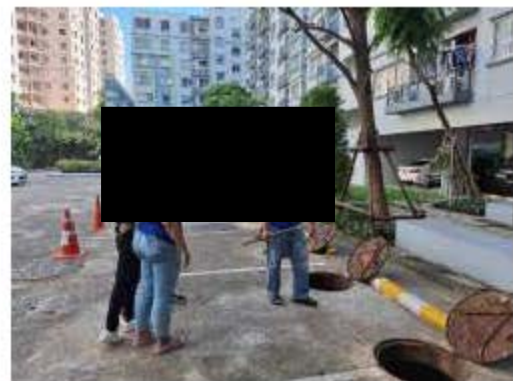
การสูบน้ำมัน/ตะกอนระบบบำบัดน้ำเสีย
