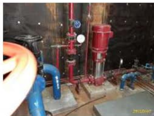
ระบบจ่ายน้ำดับเพลิงอาคาร A
