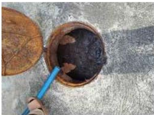
การสูบน้ำมัน/ตะกอนระบบบำบัดน้ำเสีย
