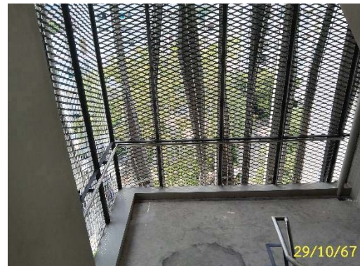
ช่องเปิดระบายอากาศด้วยวิธีธรรมชาติบันไดหนีไฟ
