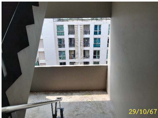
ช่องเปิดระบายอากาศด้วยวิธีธรรมชาติบันไดหนีไฟ
