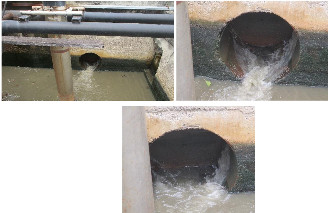
ภาพที่ 3-5 ตรวจสอบพบ ยางกันน้ำเข้า-ออก ชำรุด เสื่อมสภาพ
