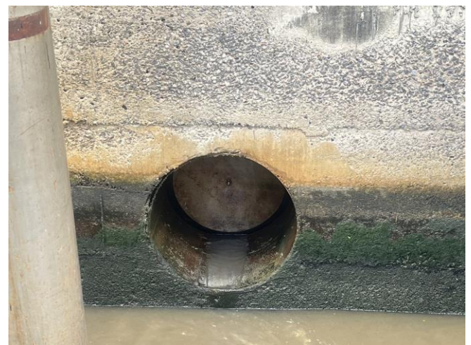
ภาพที่ 3-8 ดำเนินการเปลี่ยนยางกันน้ำเข้า-ออก ที่เสื่อมสภาพ
