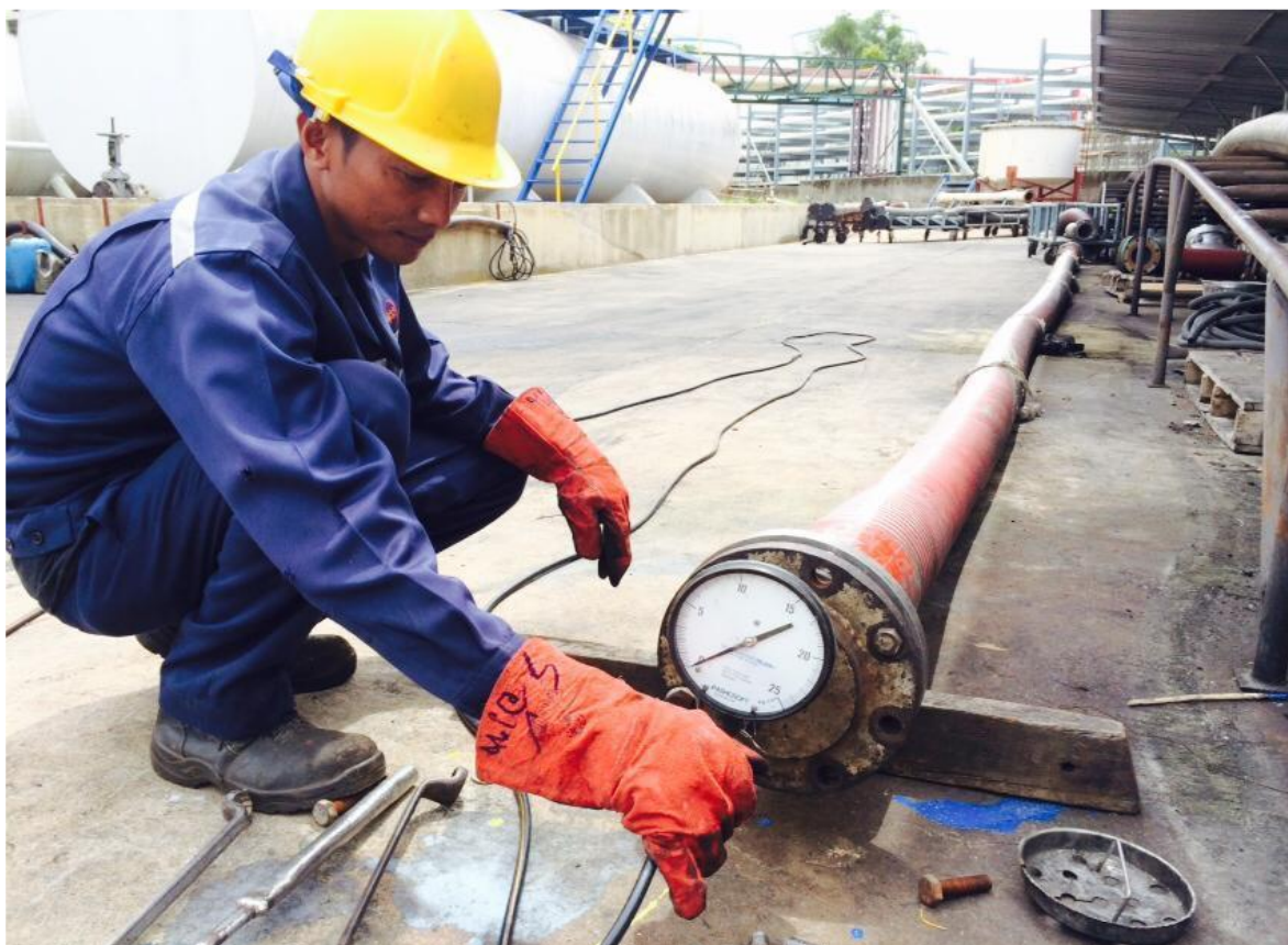
ภาพแสดงการตรวจสอบสภาพ FLEXIBLE HOSE ที่ใช้ในการขนถ่ายสินค้าจากเรือ
