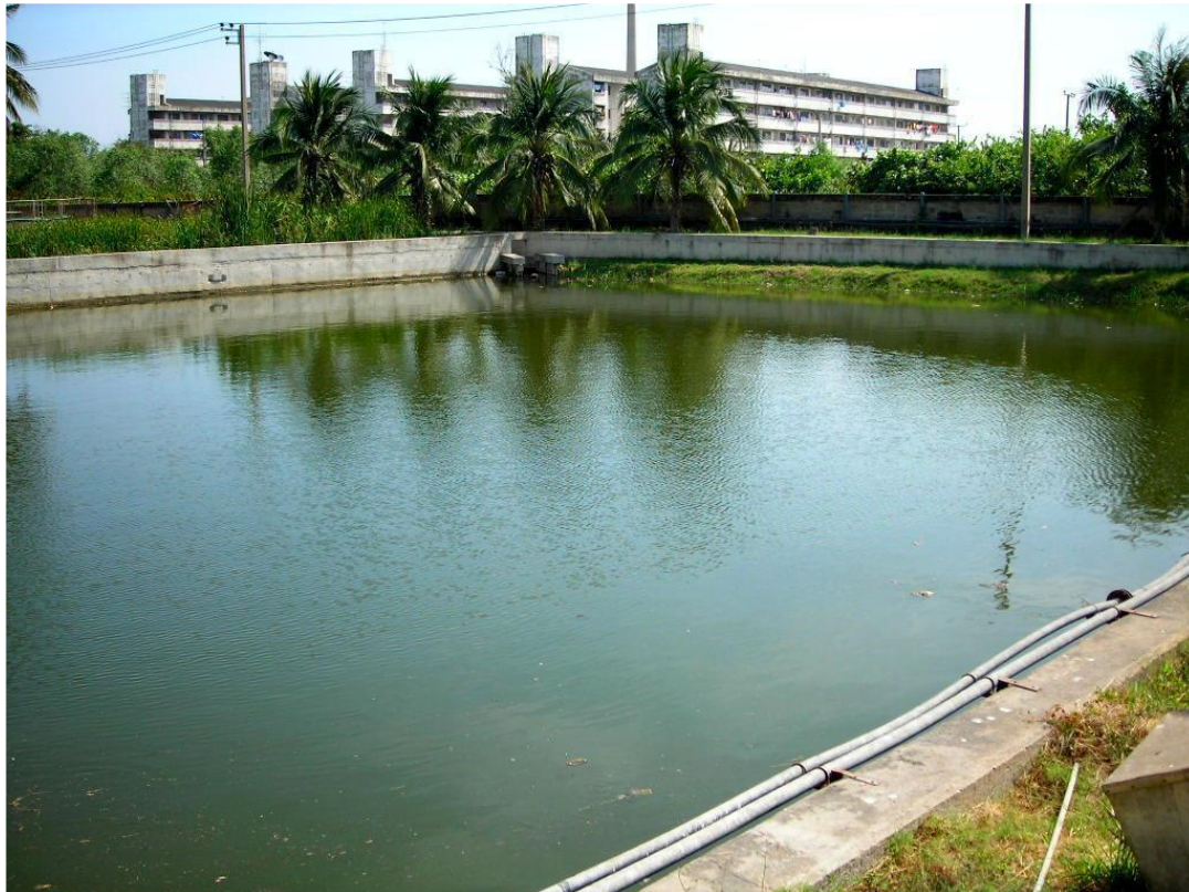
ภาพที่ 3-10 บ่อตกตะกอน (Sedimentation Pond)
