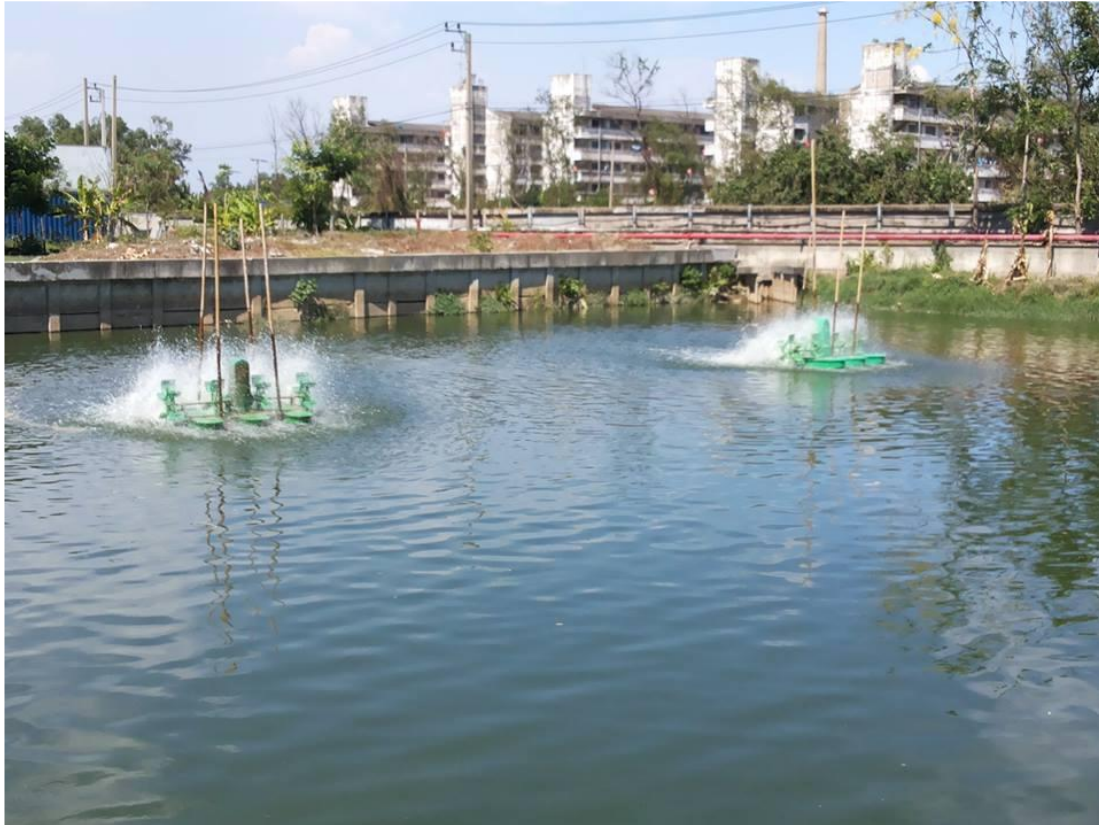
ภาพที่ 3-9 บ่อเติมอากาศ (Aeration Pond)
