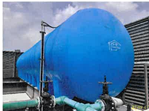
ถังสำรองน้ำใช้ชั้นคาตฟ้า อาคาร B
