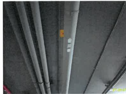
หัวรับน้ำฝนจากชั้นหลังคาอาคาร B
