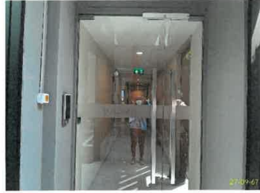
ระบบ Key Card เข้า-ออกอาคาร B
