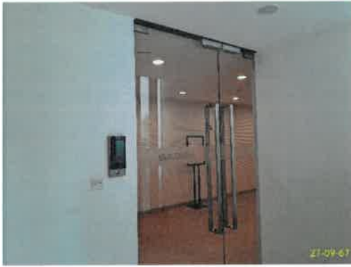
ระบบ Key Card เข้า-ออกอาคาร A
