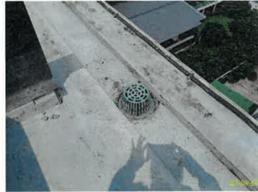
หัวรับน้ำฝนจากชั้นหลังคาอาคาร B
