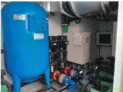
เครื่องสูบน้ำใช้ชั้นคาตฟ้า อาคาร B
