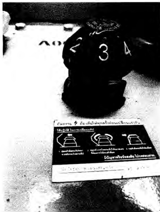
ตำแหน่งแท็บปรับแรงดันไฟฟ้า
