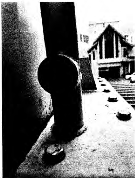
ระดับน้ำมันหม้อแปลงไฟฟ้า
