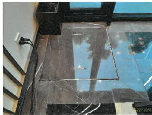
ฝาลังน้ำเพื่อการอุปโภค-บริโภค ชั้นใต้ดิน อาคาร A
