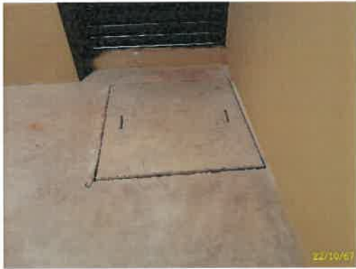
ฝาทรงน้ำเพื่อการดับเพลิงชั้นใต้ดิน อาคาร A
