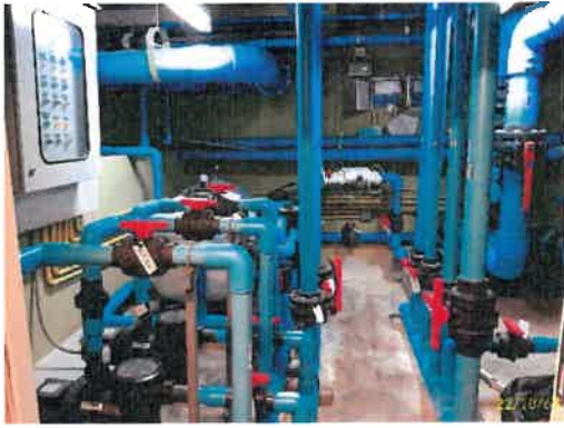
เครื่องกรองสรวายน้ำอาคาร B
