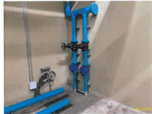
เครื่องสูบน้ำการระบายน้ำขึ้นใต้ดินตัวที่ 1 อาคาร A
