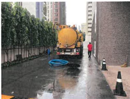
สูบล้างระบบบำบัดอาคาร A
