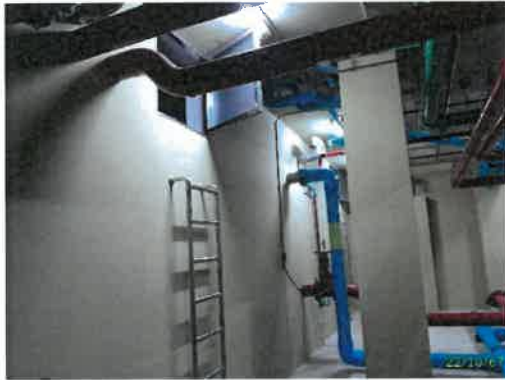
ถัง และฝาทรงน้ำเพื่อการดับเพลิงชั้น 28M อาคาร A
