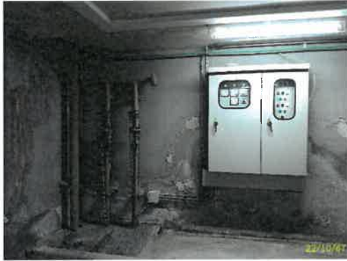
เครื่องสูบน้ำ และตัวควบคุมการระบายน้ำชั้นใต้ดินอาคาร B ท่อระบายน้ำภายในอาคาร (ต่อ)
