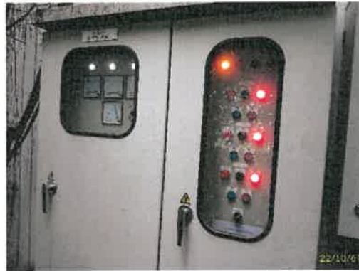
ตู้ควบคุมบ่อสุดท้ายก่อนปล่อยลงสาธารณะ
