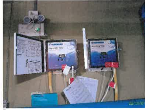
เครื่องกรองสรวายน้ำอาคาร B
