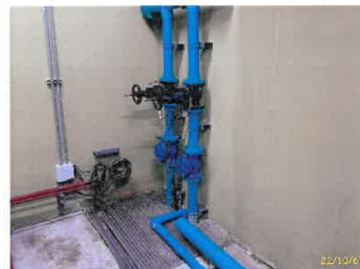
เครื่องสูบน้ำการระบายน้ำขึ้นใต้ดินตัวที่ 2 อาคาร A
