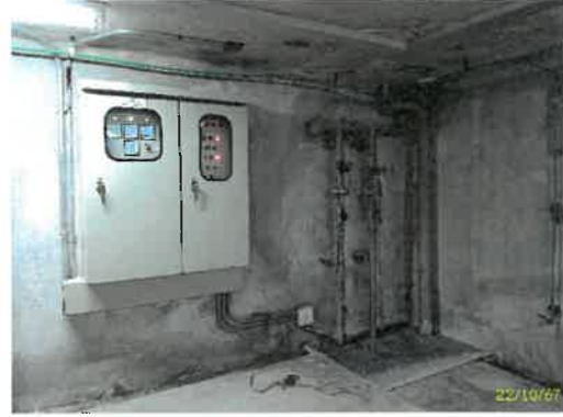
เครื่องสูบน้ำ และตัวควบคุมการระบายน้ำชั้นใต้ดินอาคาร B ท่อระบายน้ำภายในอาคาร (ต่อ)
