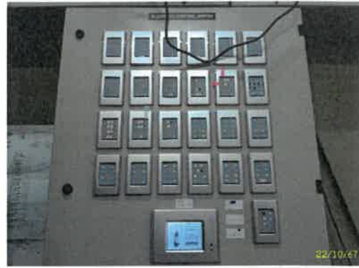
ตัวควบคุมระดับแสงสว่างอาคาร B
