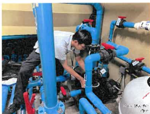
ล้างกรองสรวายน้ำอาคาร A
