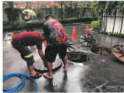
สูบล้างระบบบำบัดอาคาร A
