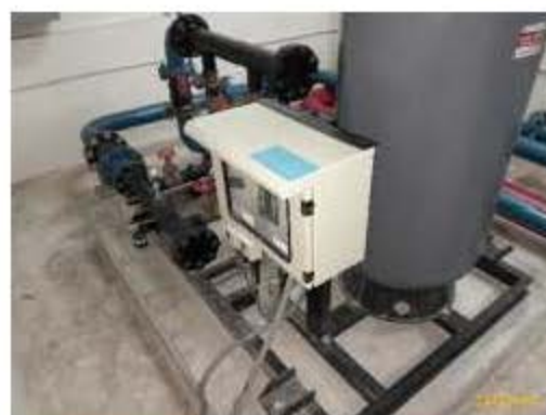
เครื่องสูบน้ำเสริมแรงดันชั้นตาดฟ้า
