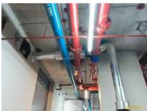
ระบบท่อน้ำดับเพลิงหรือท่อน้ำขึ้น
