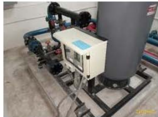
เครื่องสูบน้ำเสริมแรงดันชั้นตาดฟ้า
