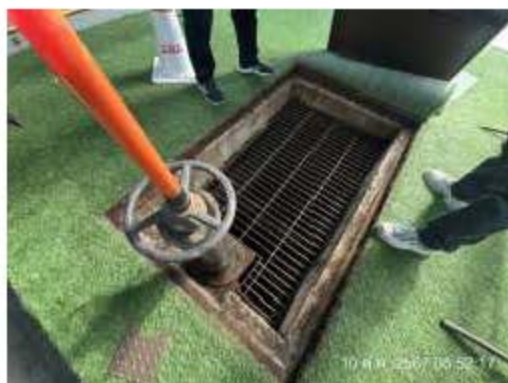
ตะแกรงดักมูลฝอยที่บ่อฟักน้ำสุดท้าย
