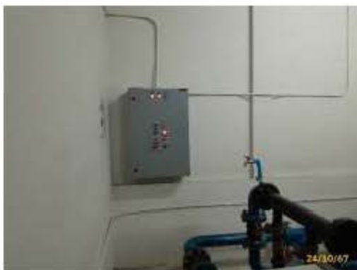
แผงควบคุมเครื่องสูบน้ำชั้นตาดฟ้า
