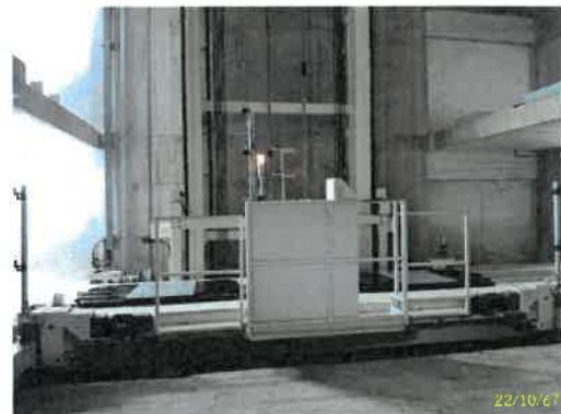
ระบบการนำรถออกจากที่จอดอัตโนมัติ
