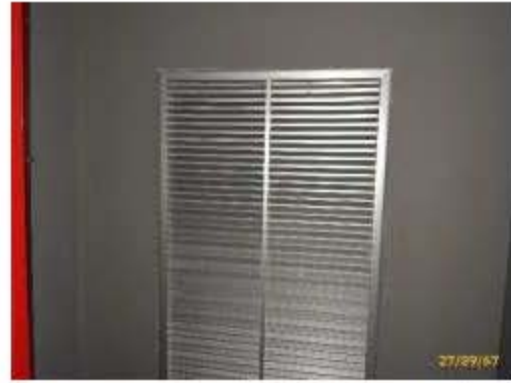
ระบบอัดอากาศบริเวณโด่งลิฟต์ดับเพลิง
