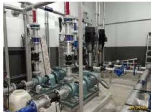
ระบบปั้มน้ำใช้ขึ้นใต้ดิน
