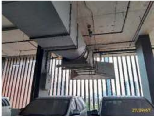
ระบบอัดอากาศบริเวณโด่งลิฟต์ดับเพลิง
