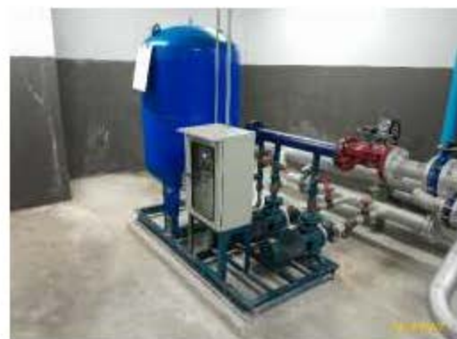
ระบบปั้มน้ำใช้ขึ้นตลาดฟ้า
