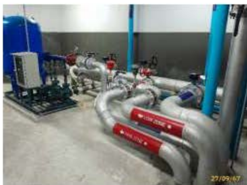
ระบบปั้มน้ำใช้ขึ้นตลาดฟ้า
