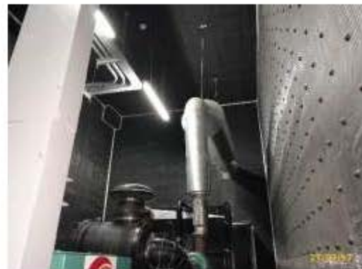
พ่อระบายอากาศเครื่องกำเนิดไฟฟ้าสำรอง
