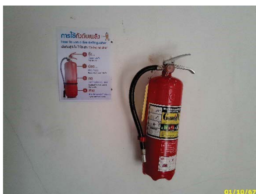
ถังดับเพลิงเคมี ชนิด A-B-C
