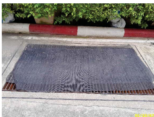
บ่อพักน้ำสุดท้ายก่อนระบายออกสู่สาธารณะ
