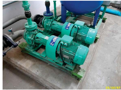
Booster Pump ชั้นดาดฟ้า
