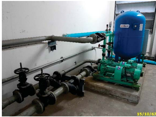
Booster Pump ชั้นดาดฟ้า
