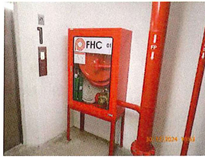
รูปที่ 1.8-2 ระบบท่อยืน (Stand Pipe)
