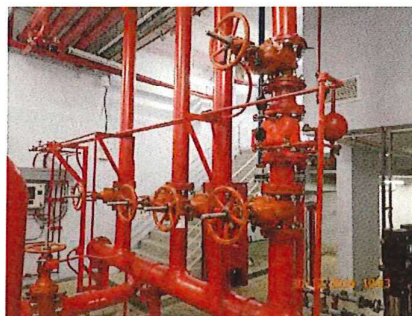
รูปที่ 1.8-2 ระบบท่อยืน (Stand Pipe)
