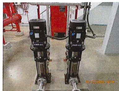
ภาพที่ 2.2-10 ระบบปั้มน้ำประปาชั้นใต้ดินและชั้นดาดฟ้า
