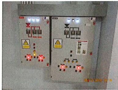
ภาพที่ 2.2-10 ระบบปั้มน้ำประปาชั้นใต้ดินและชั้นดาดฟ้า
