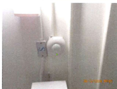
ภาพที่ 2.2-21 เลือกใช้หลอดไฟLED เพื่อประหยัดไฟพลังงาน และ โหมดเปิด-ปิดสว่างอัตโนมัติ
