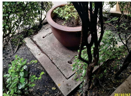
บ่อพักน้ำ พร้อมฝาครอบท่อ และตะแกรงดักขยะ
